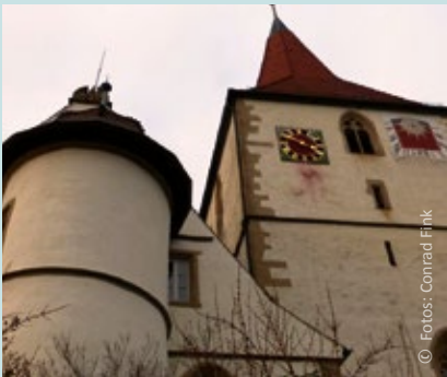
Amanduskirche vor der Renovierung
