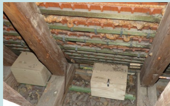
Nist-/Brutkästen für Mauersegler im Traufbereich des Turms, ebenfalls mit rückseitigen Klappen.
