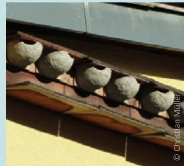
Nisthilfen für Mehlschwalben an einem Neubau-Reihenhausprojekt, Remseck-Pattonville
