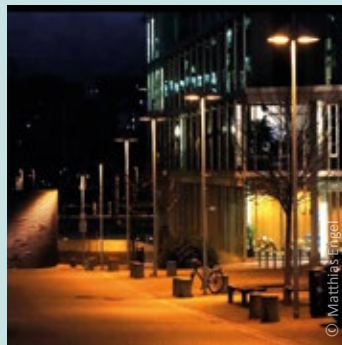
Abb.6: Voll abgeschirmte Straßenbeleuchtung
