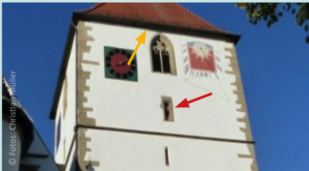
Festgestellte Einfluglöcher der Turmdohlen unterhalb der Traufe (gelber Pfeil) und der Turmfalken (roter Pfeil)
