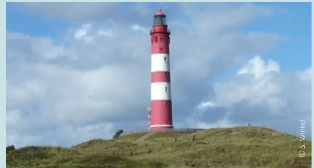
Abb 2.: Leuchtturm auf der Nordseeinsel Amrum. In früheren Zeiten hatte sein Licht eine Monopolstellung und war ein eindeutiges Signal.
